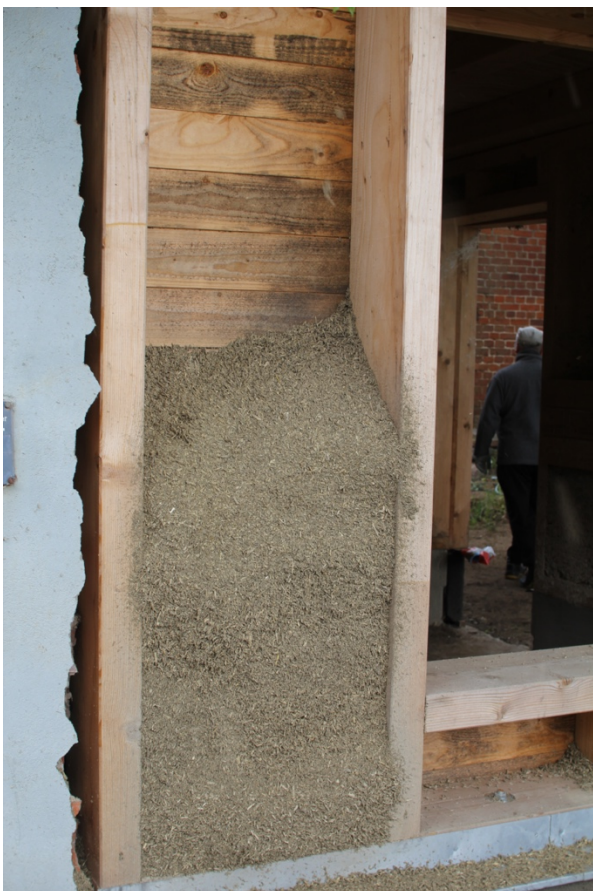
Die aufgetragene Schicht direkt nach dem Sprühen: Sie ist schon hart und kaum noch formbar · Foto: Nina Reisinger
