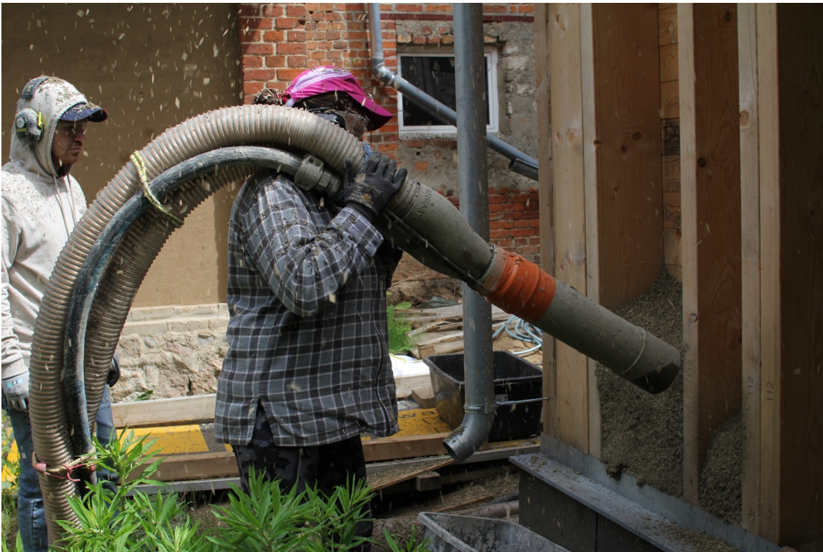
Den Sprühschlauch über der Schulter, wird das Material von oben nach unten auf die Fläche gesprüht. Dabei sollte man gute Schutzkleidung tragen, denn die Hanfteile landen überall · Foto: Nina Reisinger
