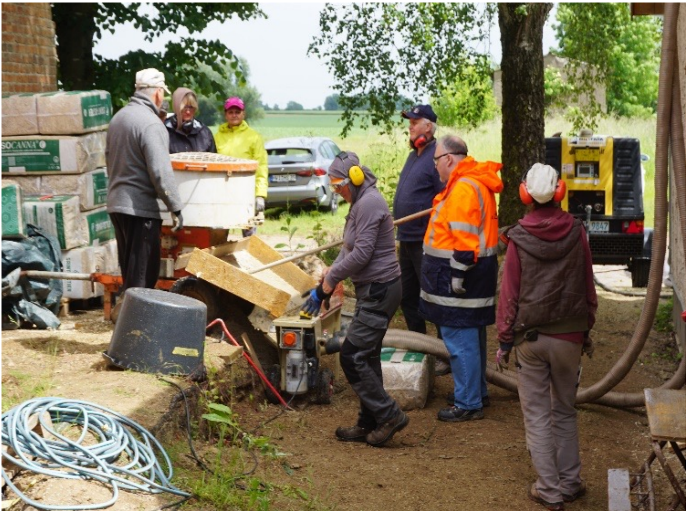
Die Baustelle wird eingerichtet: Material, Mischer, Materialversorgungswagen, im Hintergrund wird der Kompressor aufgestellt.
