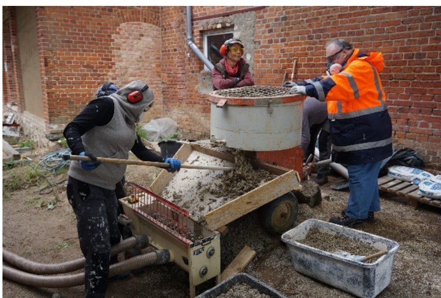
Mischer und Versorgungswagen mit Schläuchen – Material wird angesaugt und zur Sprühlanze transportiert. (Foto: Hans-Jürgen Lindemann)
