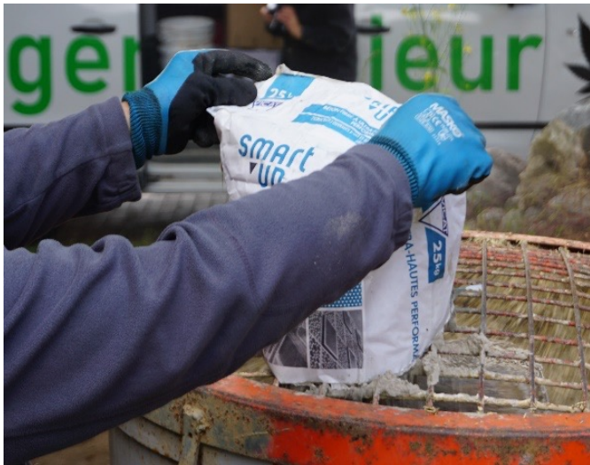
Hanfschäben und Kalk in den Mischer einfüllen.
