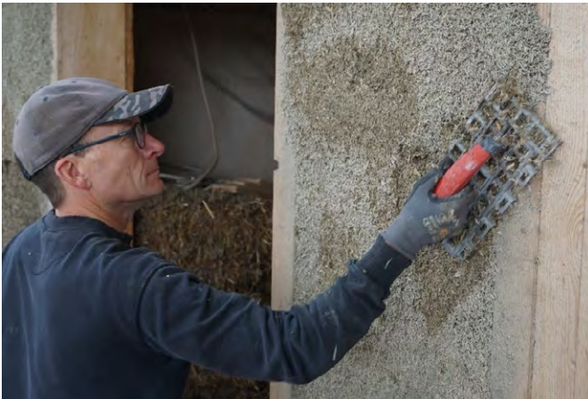
Überstehende Teile der gesprühten Wand werden entfernt. Hier mit dem Putzkratzer.
