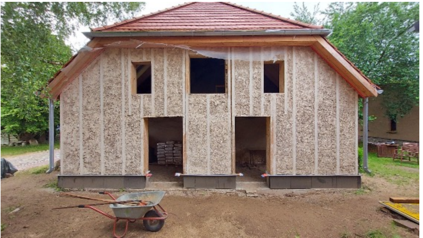
Bild oben: Außenansicht eines Giebels der komplett im Hanfkalk-Sprühverfahren umgesetzt wurde.
