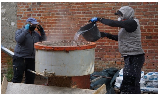
Geeignetes Mischungsverhältnis durch Ausprobieren ermitteln. Wasser zugeben – Am besten in einem Eimer mit Literangaben bereithalten.
