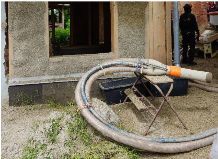
Sprühlanze mit Druckluftschlauch (Foto: Hans-Jürgen Lindemann)
