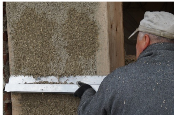
Mit der Kartätsche kann man die überstehenden Teile „abschneiden“.
