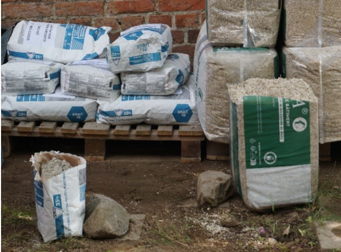
Material am Mischer bereithalten.
