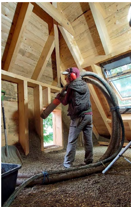
Sprühen der Innenseite der Wand im Gebäude.
