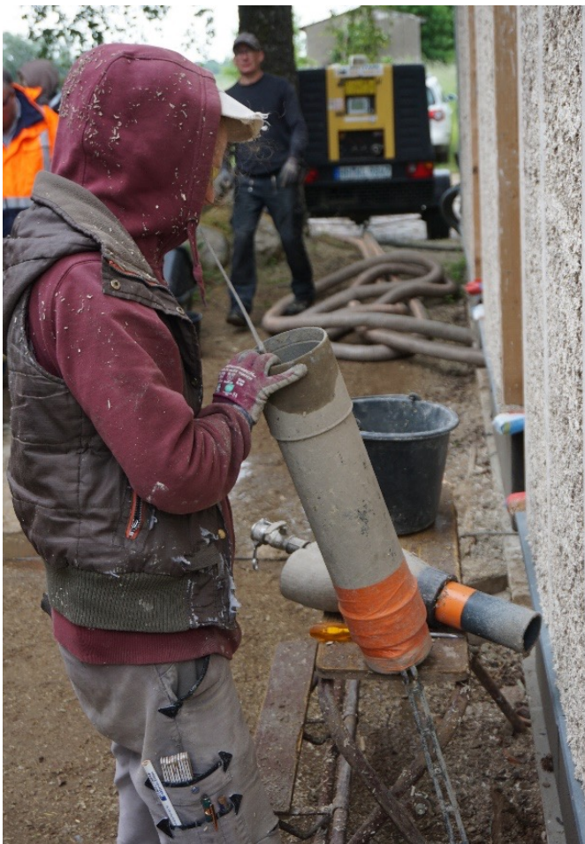
Hier wird die Sprühlanze demontiert und sorgfältig gesäubert.
