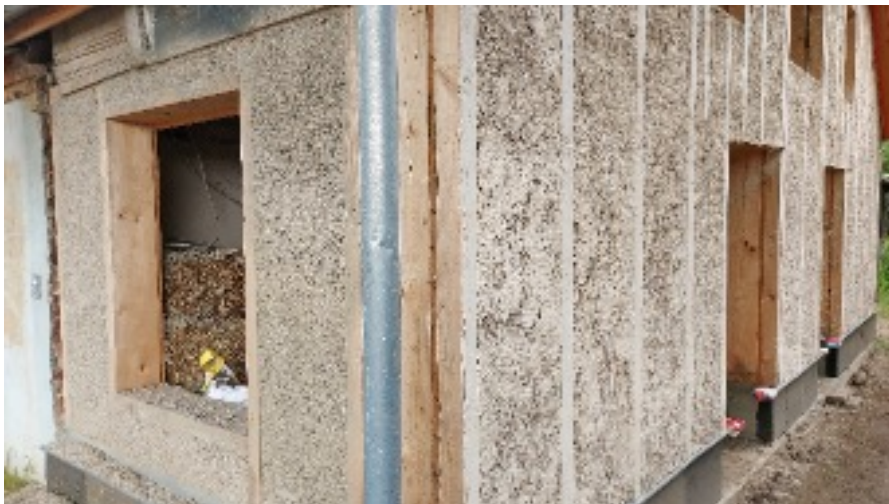
Bild oben: Außenansicht eines Giebels der komplett im Hanfkalk-Sprühverfahren umgesetzt wurde.
