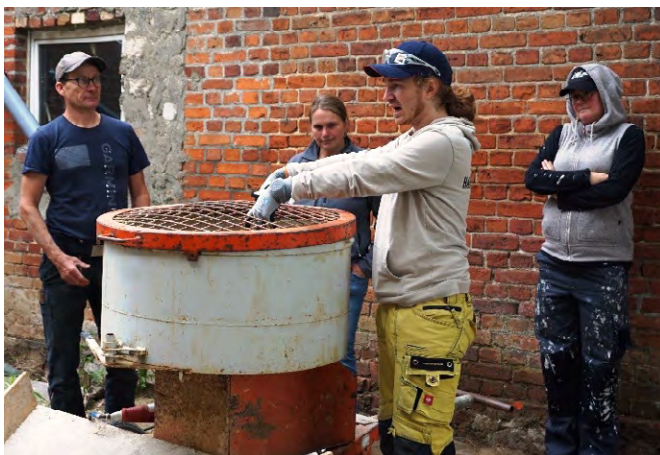
Der Schutz über dem Zwangsmischer wird erklärt, damit niemand in den laufenden Mischer greift.
