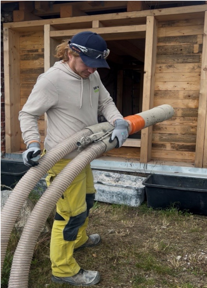
Sprühlanze und Ansaugschläuche werden zusammengesteckt.
