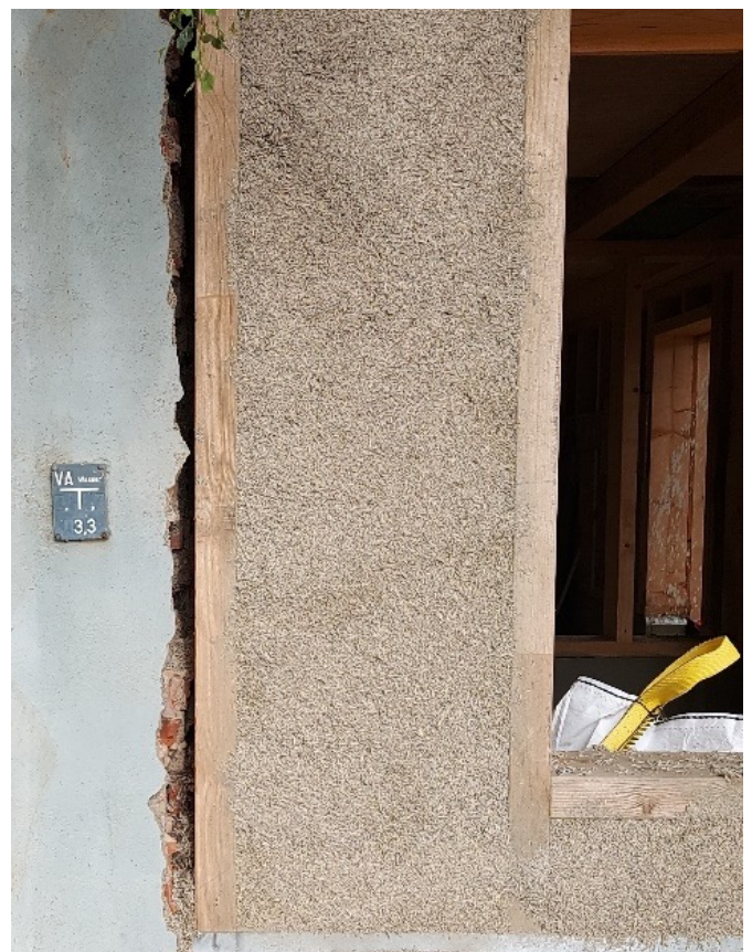
Auch wenn es auf den Fotos scheinen mag, als sei das Material noch plastisch: Nach 24 Stunden ist das Material spätestens so hart, daß man es kaum formen könnte.
