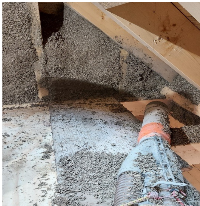
Vorteil des Sprühverfahrens: Die Ecken können hohlraumfrei gesprüht werden.
