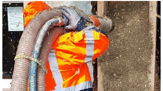
Die Sprühlanze wird über der Schulter getragen und von dort bedient.
